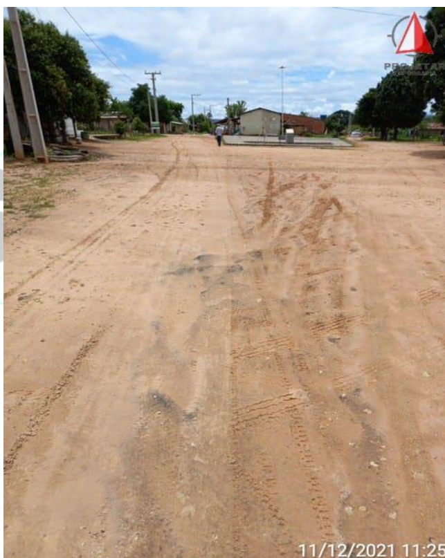
Figura 1- Fonte Projetar: Encontro da Rua Marcelina Nunes de Oliveira e Avenida Teodoro Rodrigues Ferreira
